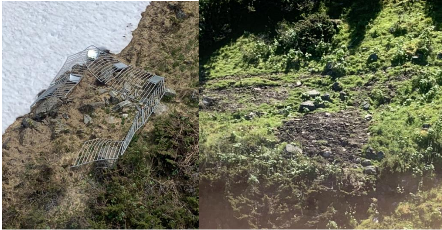
Bilde 5 og 6: Grindanlegg nr 512 i Aurland som stod i bratt terreng og var blitt ødelagt av snøen. Bilde t.h. viser området etter sanering. Her ble det øverste laget gravd ned og det ble lagt ny masse over slik at saltholdig og evt. smittefarlig masse ble gjort utilgjengelig for dyr.
